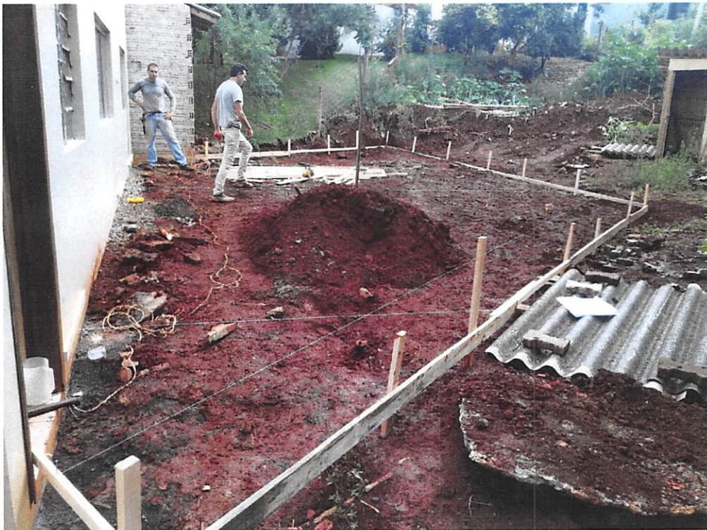
Imagem 3 – Locação de Obra
